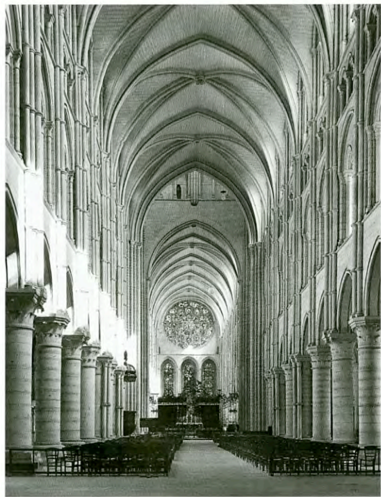
Fig. 16.7. Laon Cathedral. Interior, 1165–1205
